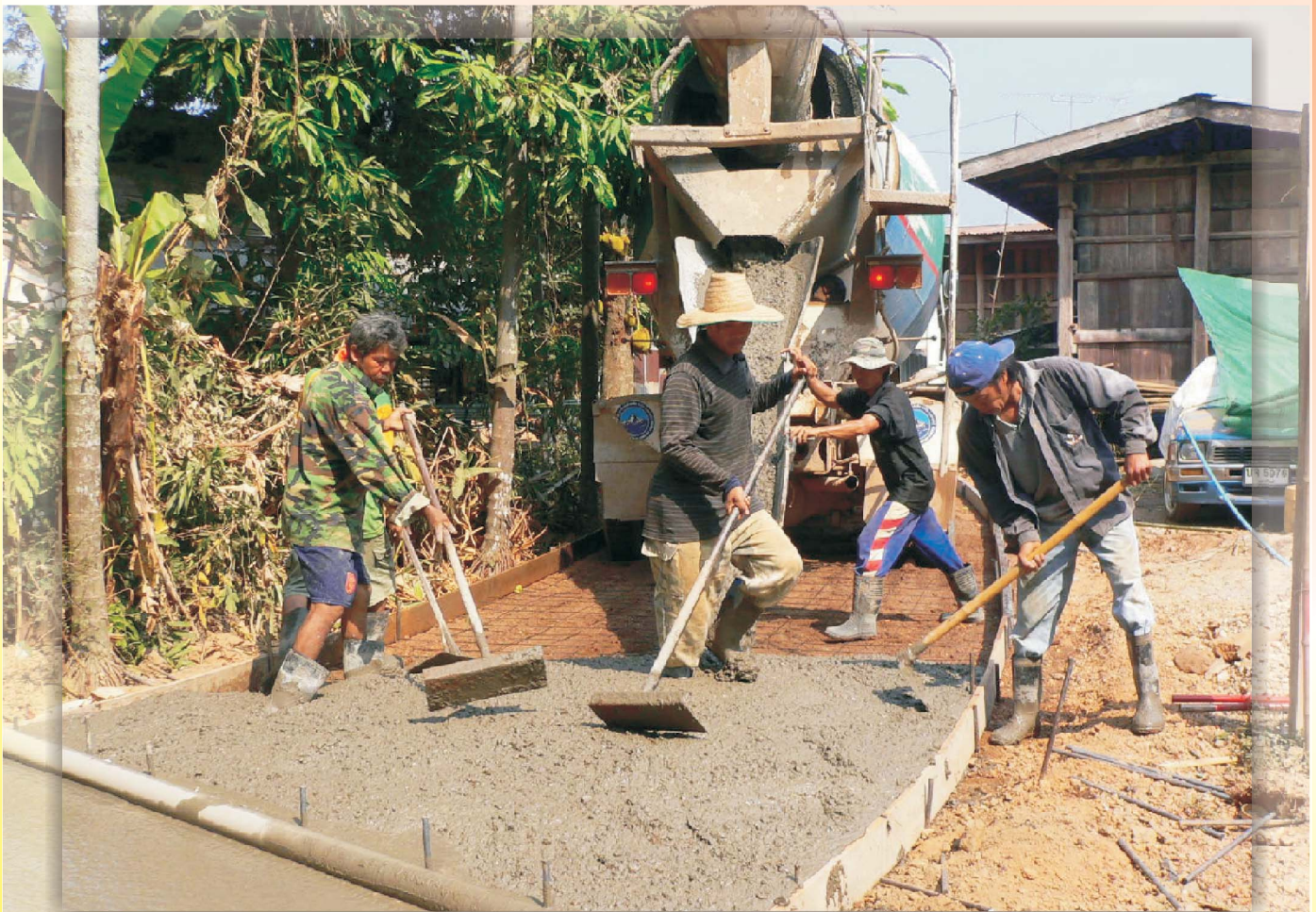
ก่อสร้างถนน คสล.
