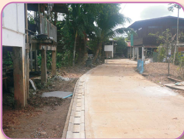
ก่อสร้างรางระบายน้ำ
