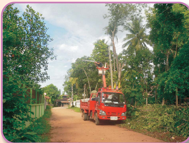
ซ่อมแซมไฟฟ้าสาธารณะ
