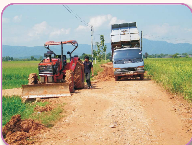
ซ่อมแซมถนนลูกรัง
